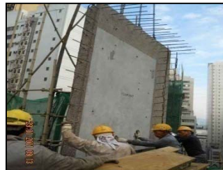
PRECAST FAÇADE (End Wall)
